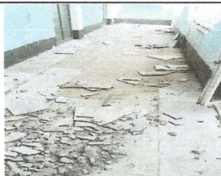
Foto 4: sustitución de piso 34 m2
