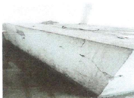
Foto 6: Reparación de plancha concreto
