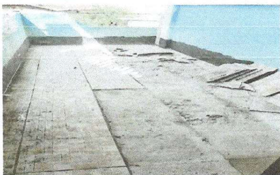
Reparación de piso 22 m2
