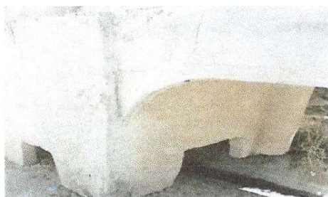
Foto 5: Sustitución de pila
