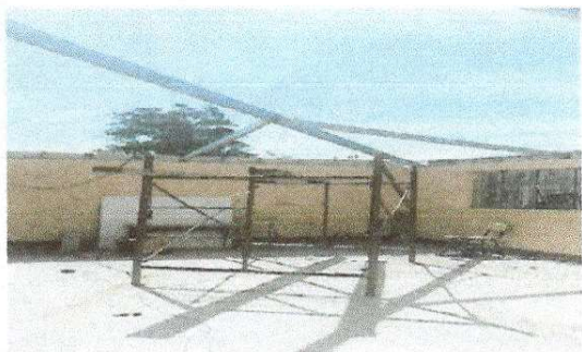
Foto 1: Sustitución de techo
